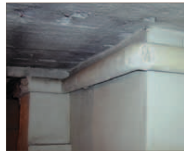
Voorbeeld ongebonden toepassing: plaasterisolatie
